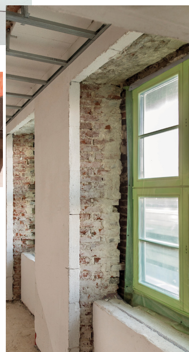
Innendämmung auf Mischmauerwerk ©Foto: Ytong
